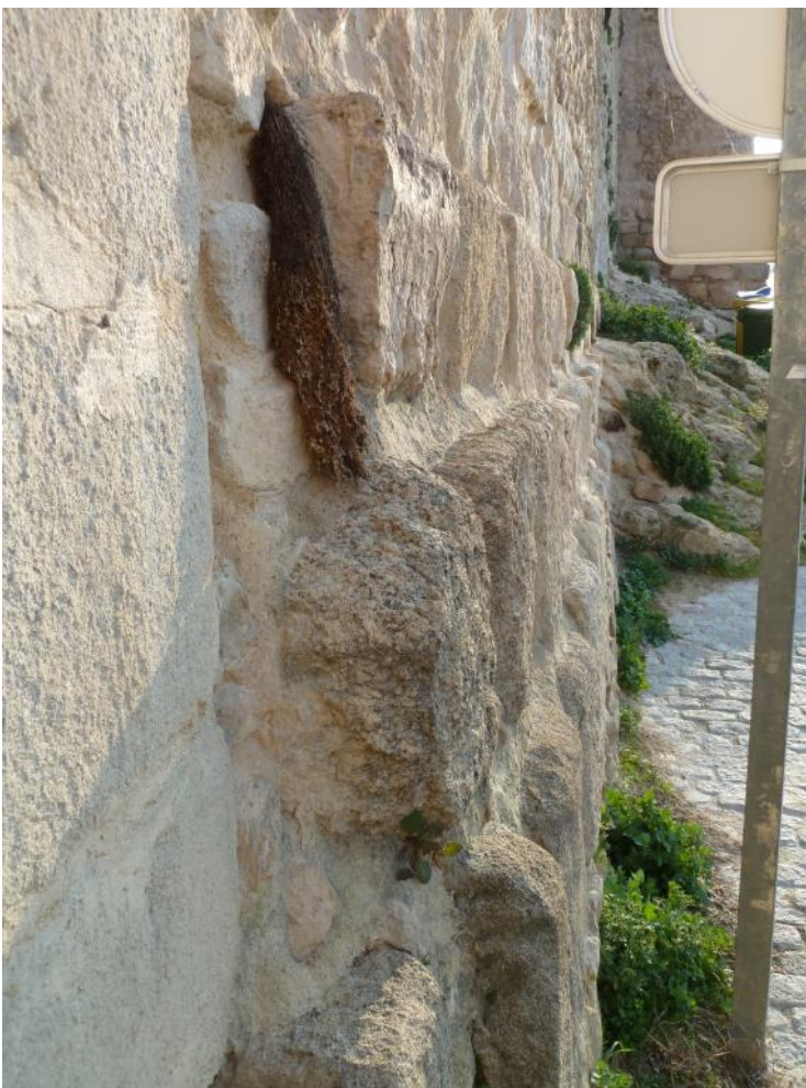
Detalle del lienzo de la muralla L6-7 con zarpa escalonada
