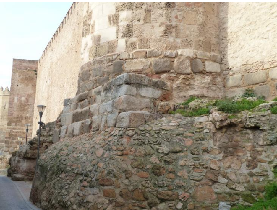
Detalle de los restos de zarpa escalonada bajo la torre T4
