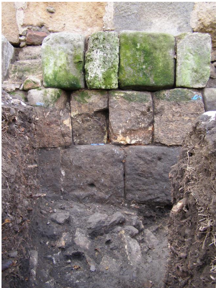
Restos de fábrica de sillería con aparejo de pseudotizón
