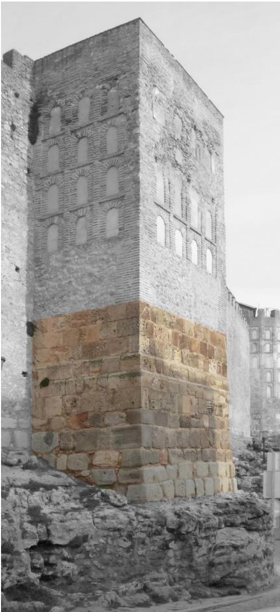
Torre de la muralla T3 con fábrica de sillería
