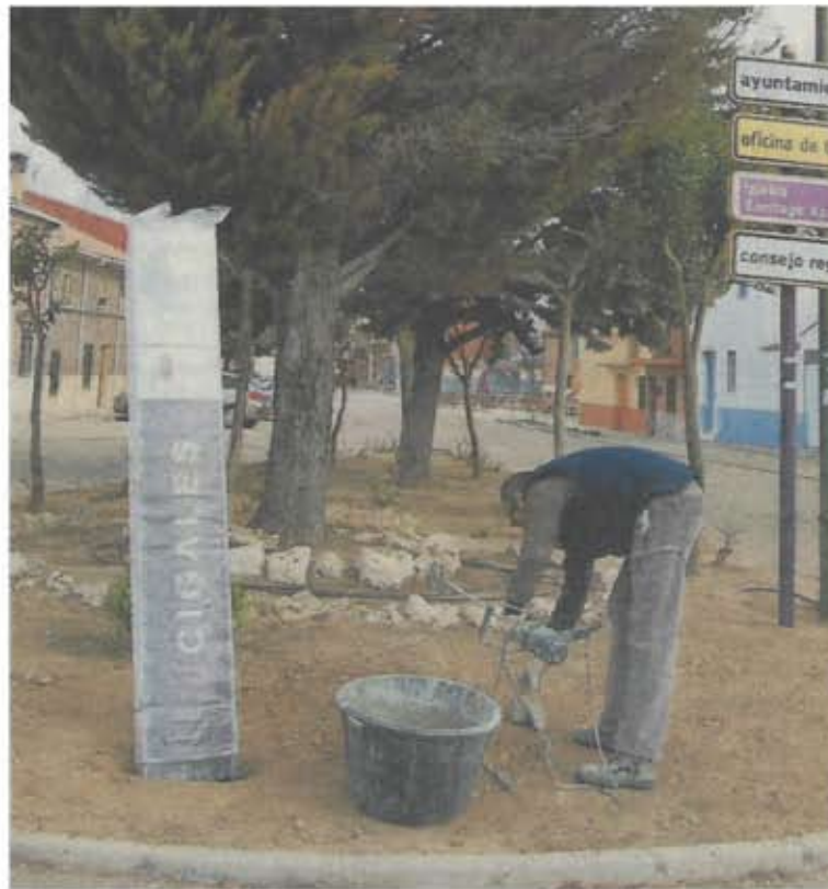
Un operario coloca una de las señales identificativas. de J. F.
